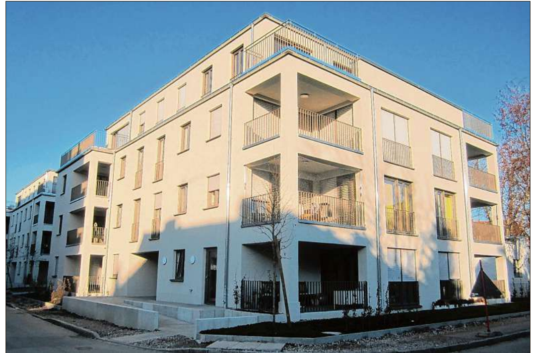
In vier Baukörpern sind im „Johannesquartier“ an der Goethe- und Bühelstraße insgesamt 47 neue Eigentumswohnungen entstanden. Foto: Ralph Lacher
